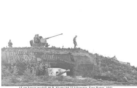
15 cm kanon modell 40 B. Skottvidd 22 kilometer. Foto Roten 1941 20 mm luftvärnsautomatkanon ovanpå. Landstigningshinder skymtar i h./Krigsarkivet.
